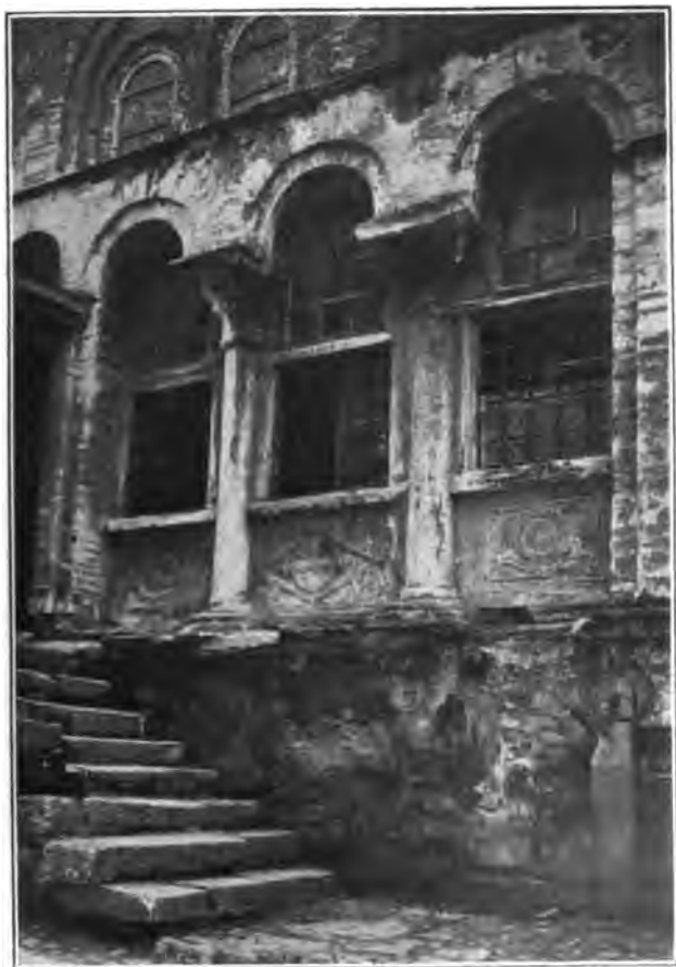
Fig. 204. — Constantinople. Kilissé-djami. Détail de la façade (Phot. Ebersolt).
